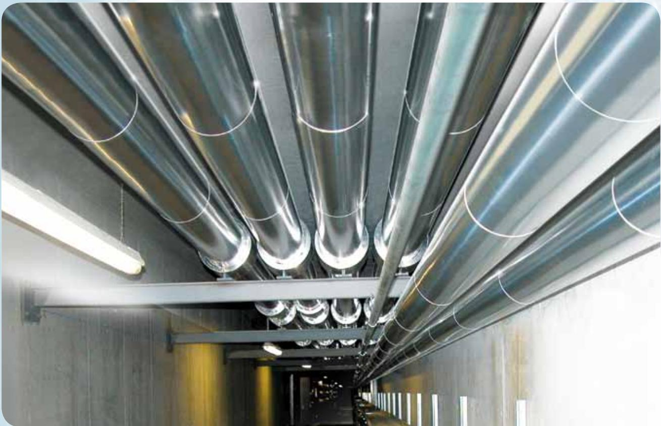
**AUTODROMO DI MONZA. TUBI AL CLAD SYSTEM CON LASTRA ELASTOMERICA K-FLEX ST**
